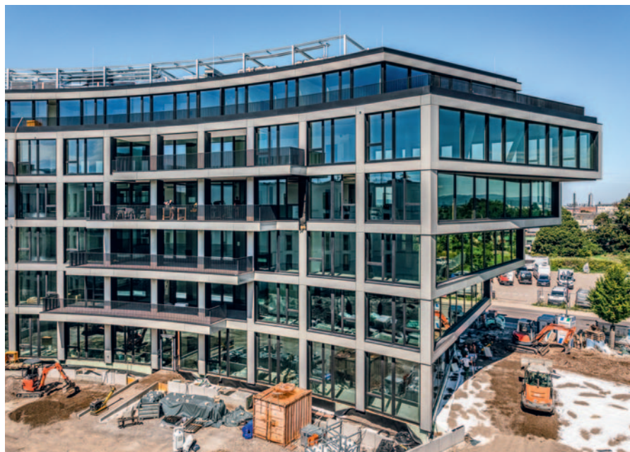
Einzigartig: Die gefächerte und über die Stockwerke gestaffelte Auskragung bringt Leichtigkeit in die Fassadengestaltung – bautechnisch hatte sie es jedoch in sich
