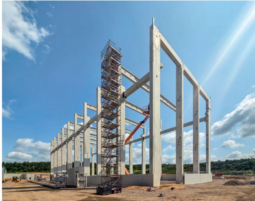
Die Hallen weisen Höhen von bis zu 25,5 m und Spannweiten von bis zu 37 m auf
