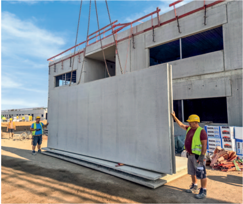
Montage der doppelschaligen Fertigteilelemente
