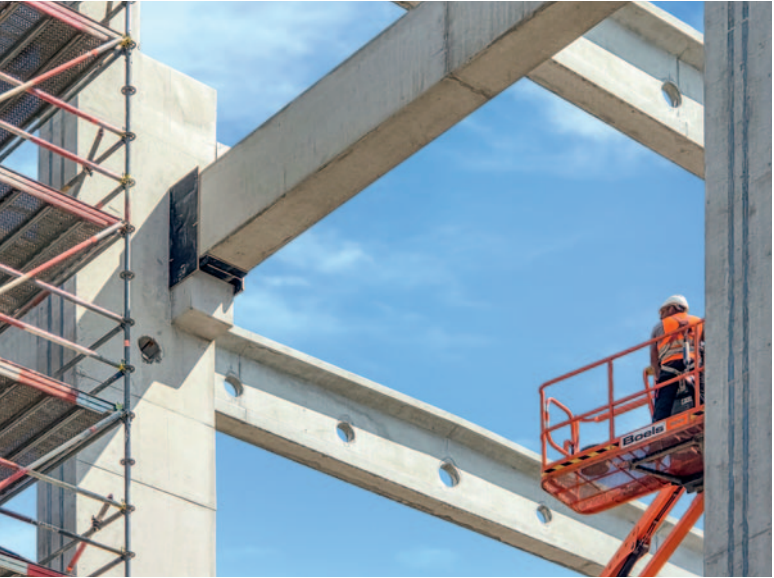
XXL-Bau erfordert Arbeiten in luftigen Höhen
