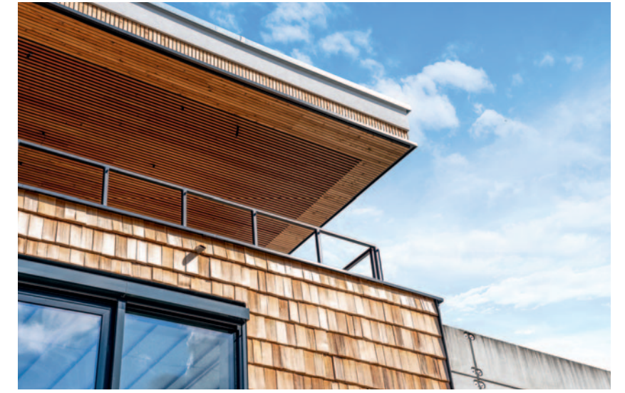
Zedernholzschindeln schmücken die Fassade
