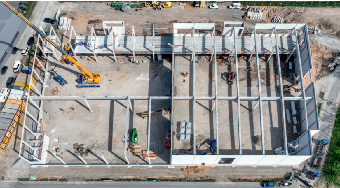
Aus der Vogelperspektive ist die klar gegliederte Gebäudestruktur gut zu erkennen
