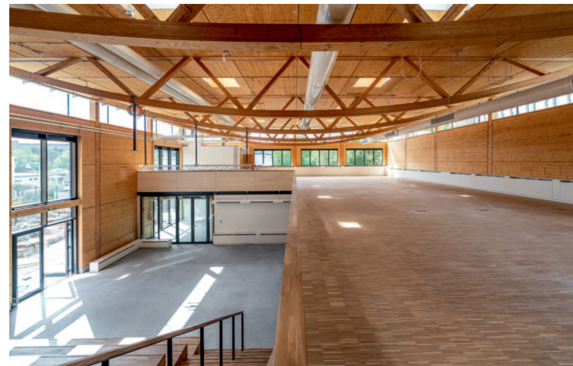
Hingucker mit statischer Relevanz: Der Fischbauchträger verleiht den modernen Open-Space-Flächen Wärme, Charakter und architektonische Tiefe
