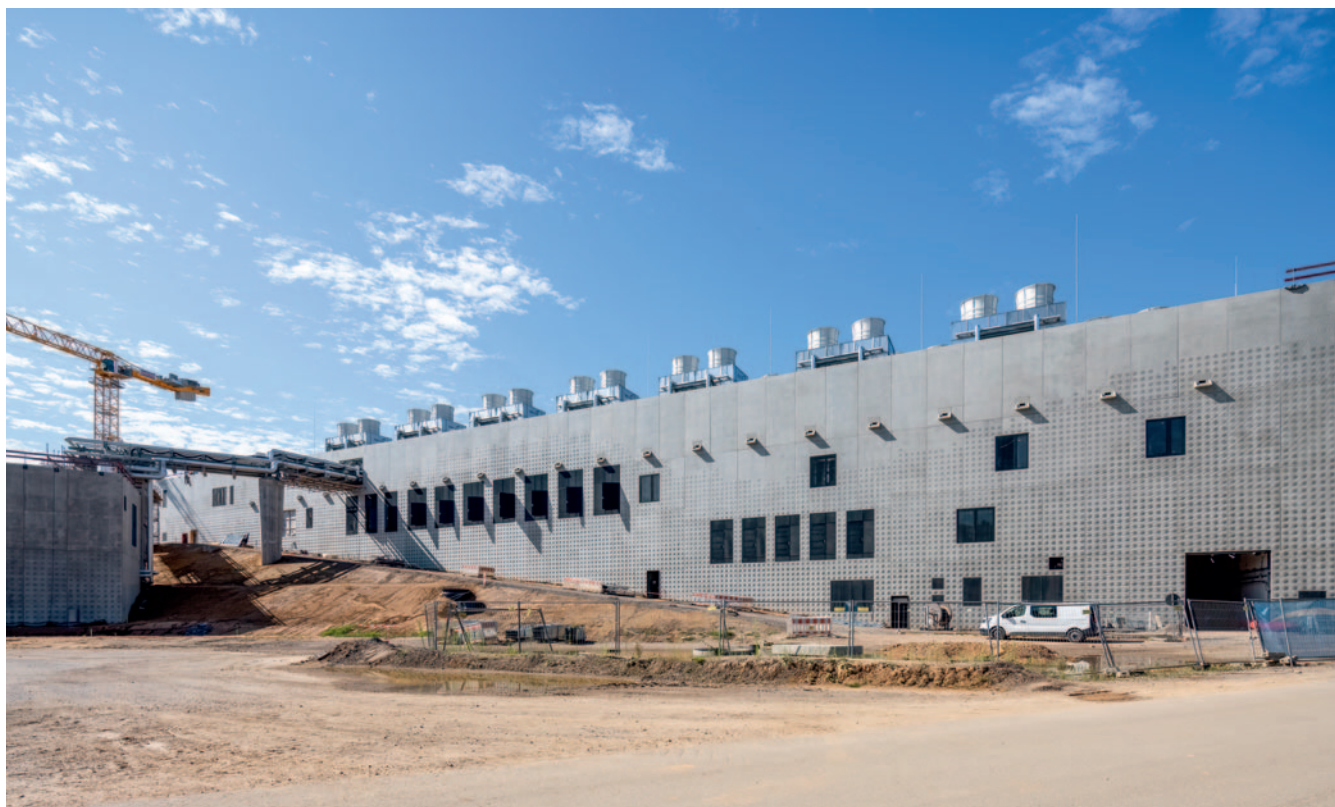
Dreßler Bau lieferte und montierte rund 21.400 m 2 Vorhangfassade aus Architekturbeton
